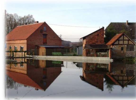
Fot. Elektrownia Gudzisz (Internet)
